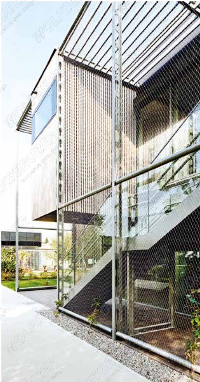
X-TEND CXE 320 m 2 , \diamond 50 mm, \phi 1,5 mm
